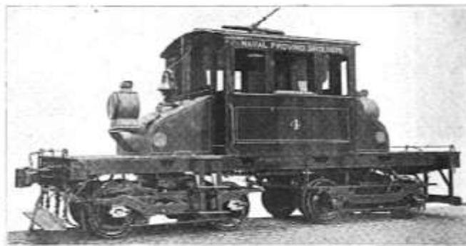
ELECTRIC LOCOMOTIVE FOR NAVAL PROVING GROUNDS
